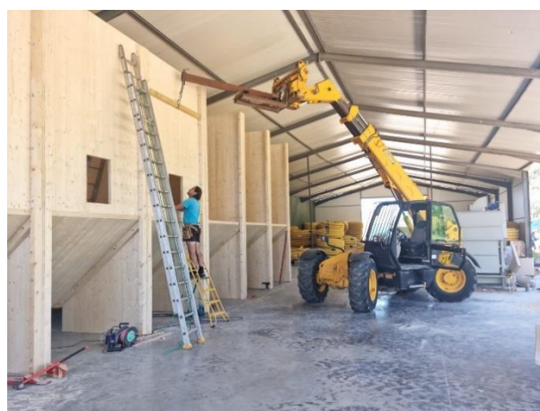
Montage des cellules, la minoterie prend forme
